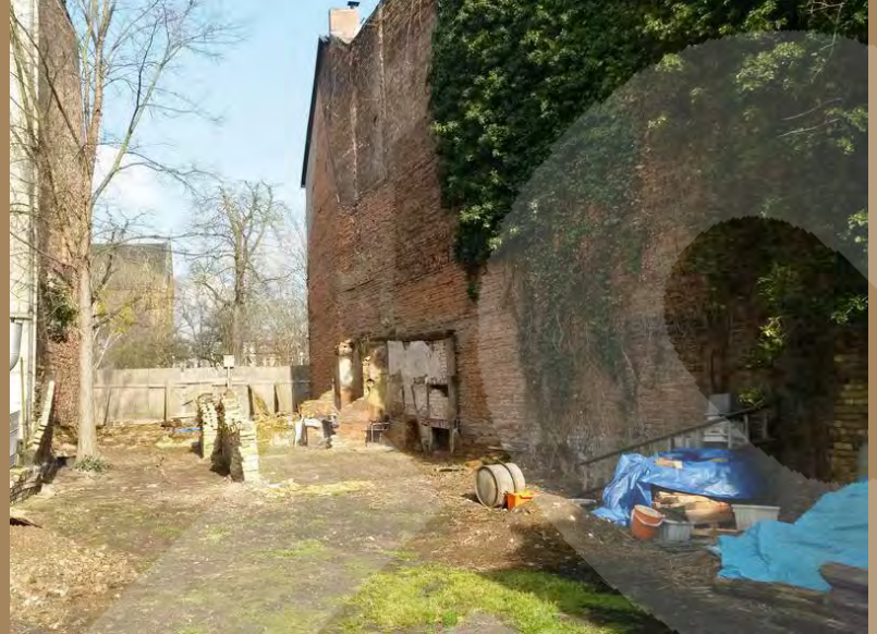
Auf dieser Brache hinter dem Haus des CVJM Wittenberg entsteht bis 2017 der Refo.Beach
